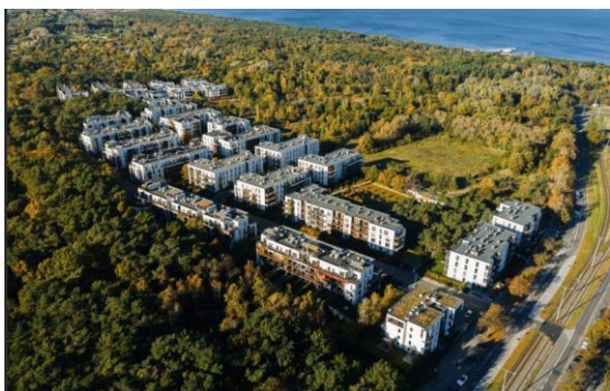
fot. widok na osiedle z lotu ptaka
