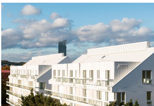
fot. budynków o numerach administracyjnych nr 77F i nr 77 od strony ul. Wita Stwosza, z widokiem w kierunku dzielnicy Oliwa
